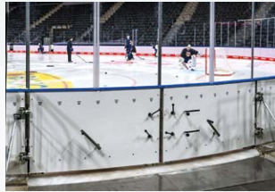
• 位于圆弧部位的设备通道门
